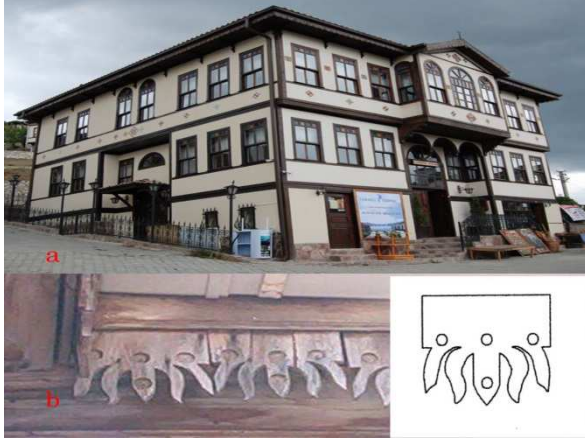
Fotoğraf: 4, a. Taraklı Çakıroğlu Evi, b. Ahşap çatı saçağı
