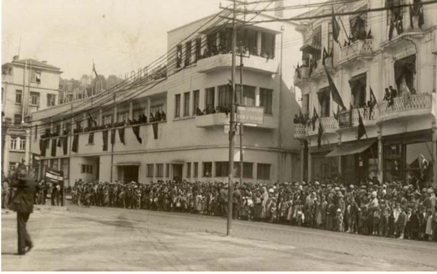
Fotoğraf 3: Gazipaşa caddesi üzerinde bulunan yeni Zonguldak Halkevi binası.
