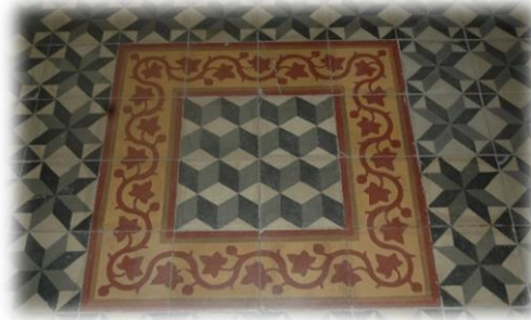
Fotoğraf 12: 1. Kat koridor döşemesi
