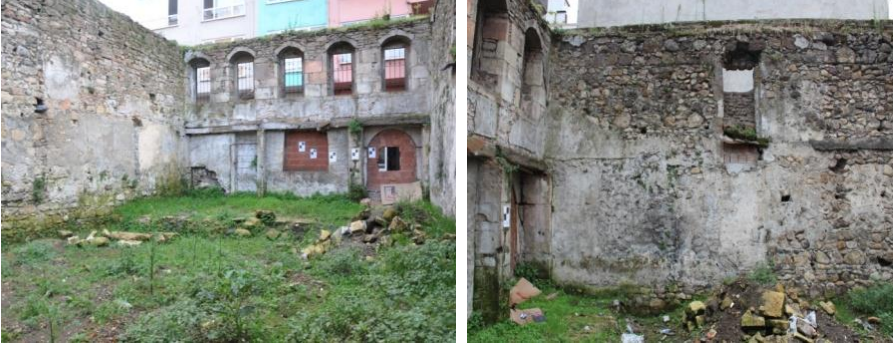
Foto No 3 ve 4: Kefeli Han güneydoğu cephe giriş kapısı ve iki bölüm arasındaki ortak duvar
