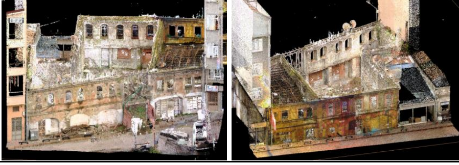
Şekil 4-5: Kefeli Han'ın İki Cepheden Lazer Tarayıcı Ölçüm Verileri ile Han'ın Üç Boyutlu Görünüşü (M.ATAMAN'dan)
