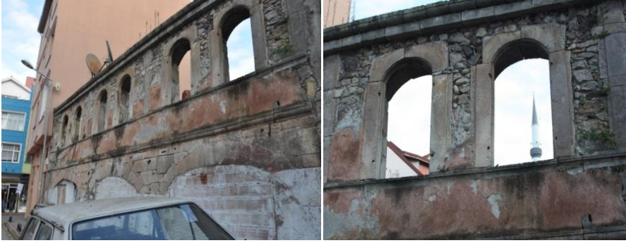
Foto No 11 ve 12: Kefeli Han kuzeybatı cephesi genel görünüş ve kuzeybatı cephesi üst kat pencereler
