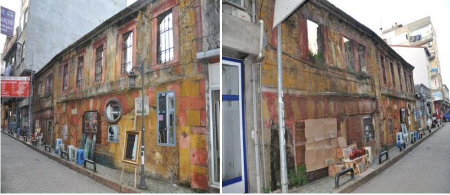
Foto No 15 ve 16: Kefeli Han güneydoğu cephesi genel görünüşü ve güneydoğu cephesi sol kısım
