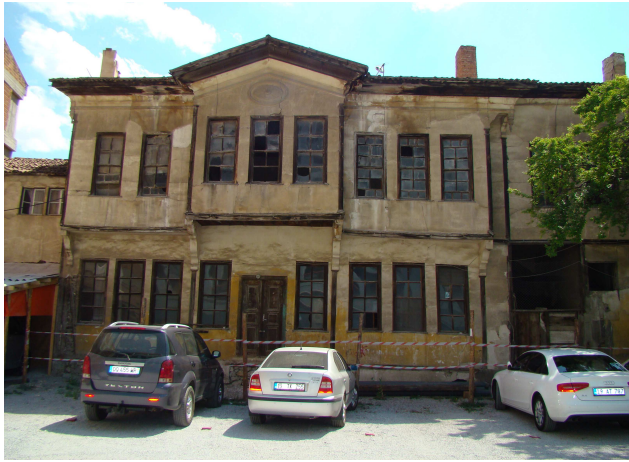
Fotoğraf 10: Dalgıçlar Konağı Genel Görünüşü
