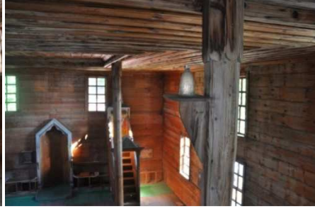
Şekil 11. Ahşap Dikmede Üst Başlık ve Fenerlik Detayı
