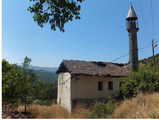
Şekil 5. Amasya Kaleköy Camii – Doğu Cephe
