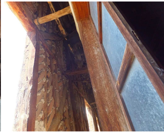
Şekil 7. Güney Cephe Duvarı İç Kısmı (Sandviç Duvar Benzeri)
