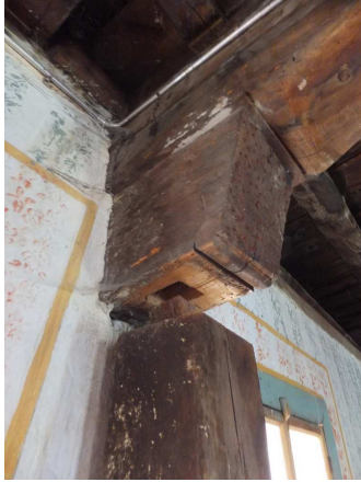
Şekil 6. Zeminde Meydana Gelen Kaymalar Nedeniyle Başlığında Ayrılmış Ahşap Direk
